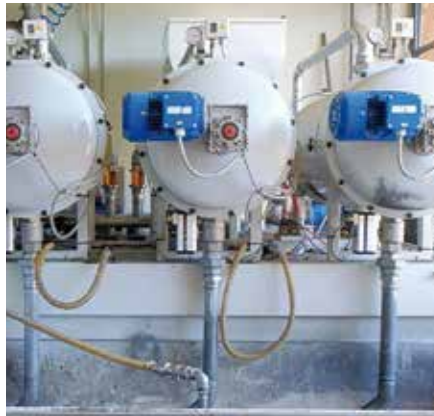
Sämtliche Schleifmaschinen bei Silmax werden zentral mit OLEA-Schmieröl versorgt.
